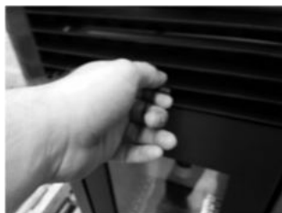
Figura 14 - Limpeza do permutador
