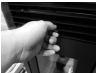
Figure 15 - Nettoyage d'échangeurs de chaleur
