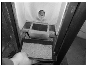
Figura 18 - Limpieza del cestillo de cenizas
